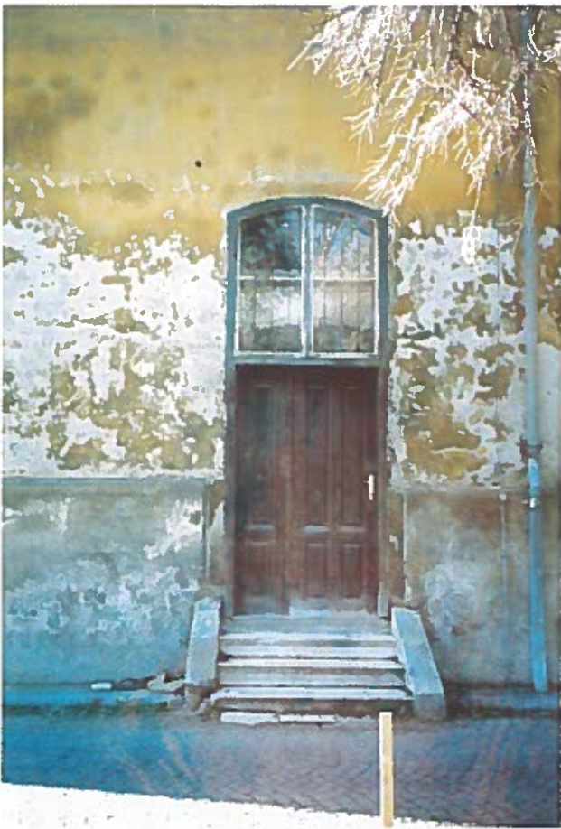
Zustand des Seitentores auf der Ostseite vor und nach der Sanierung
