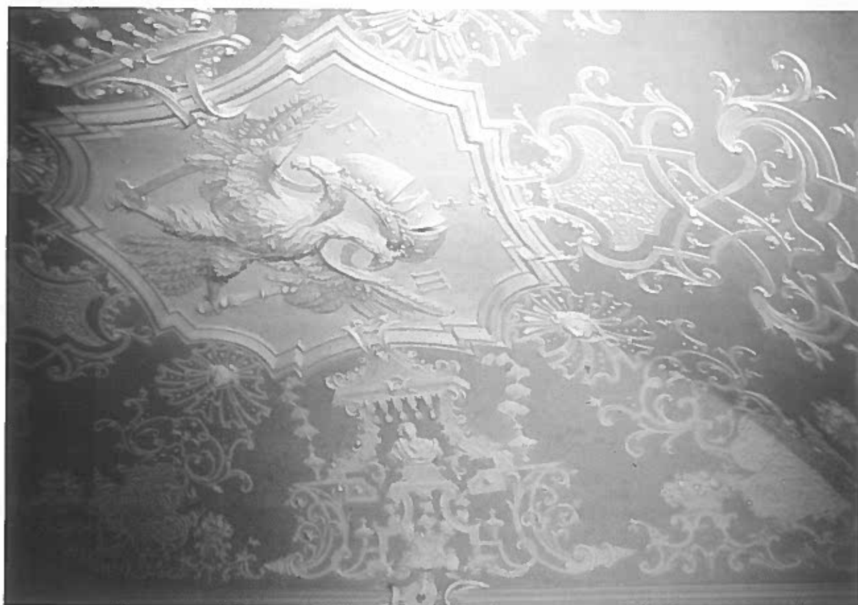
Stuckdetail, Stiegenhaus Nordseite
