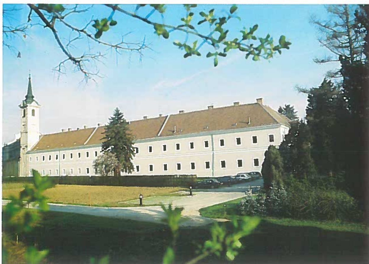
Mariabrunn nach der Generalsanierung 1994
